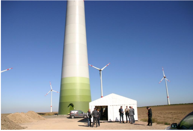
(Turm unserer Windkraftanlage)
